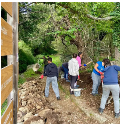
Chantier de Jeunes - Olmi Capella
